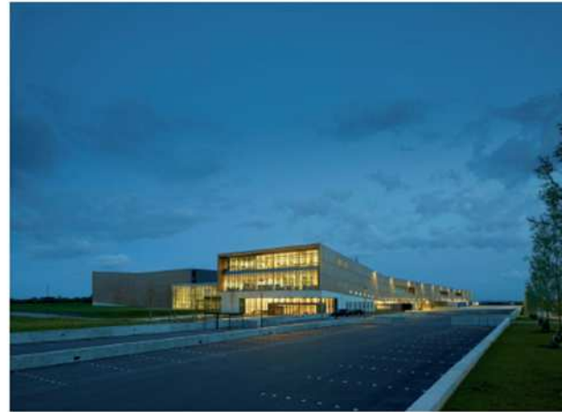
Eclairage limité dans les zones circulées
