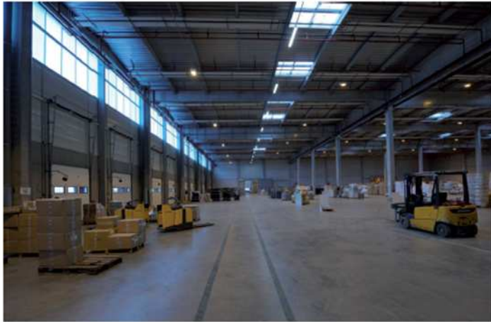
Eclairage en façade et zenital se complètent
