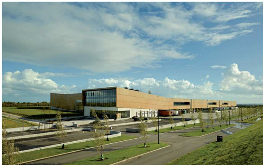
Façades et matière
