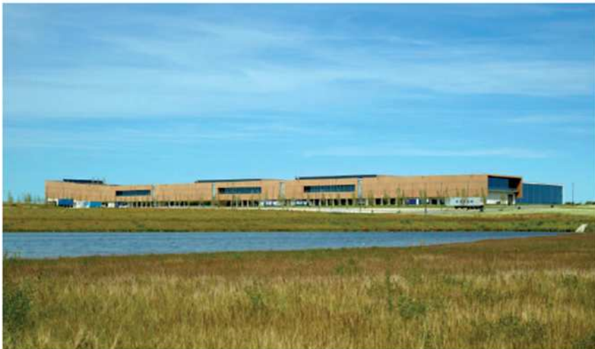
Les ouvertures en façade participe à l'écriture architecturale
