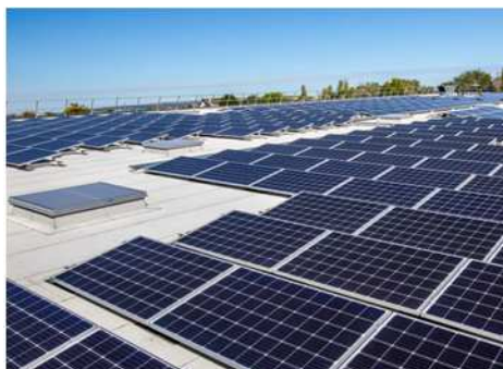
toiture équipée de panneaux photovoltaïques
